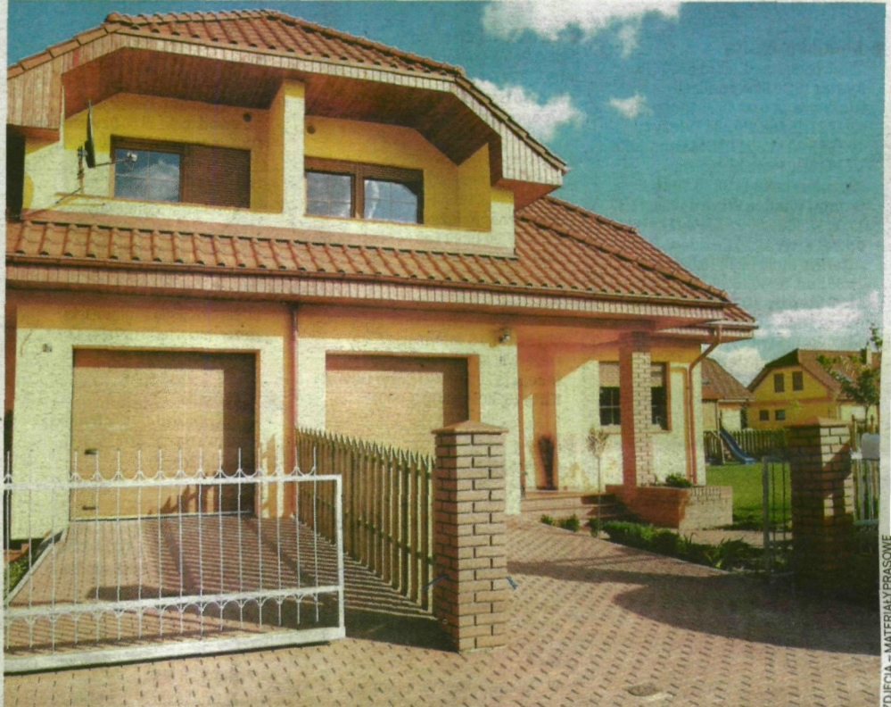
W podpoznańskim Lusówku powstaje osiedle domków jednorodzinnych Rozalin
