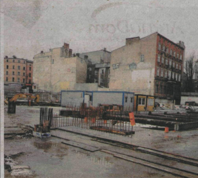
W centrum Poznania trwa budowa Galerii MM
